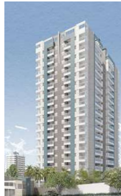
2011 San Gimignano Residencial Multifamiliar São Bernardo do Campo
